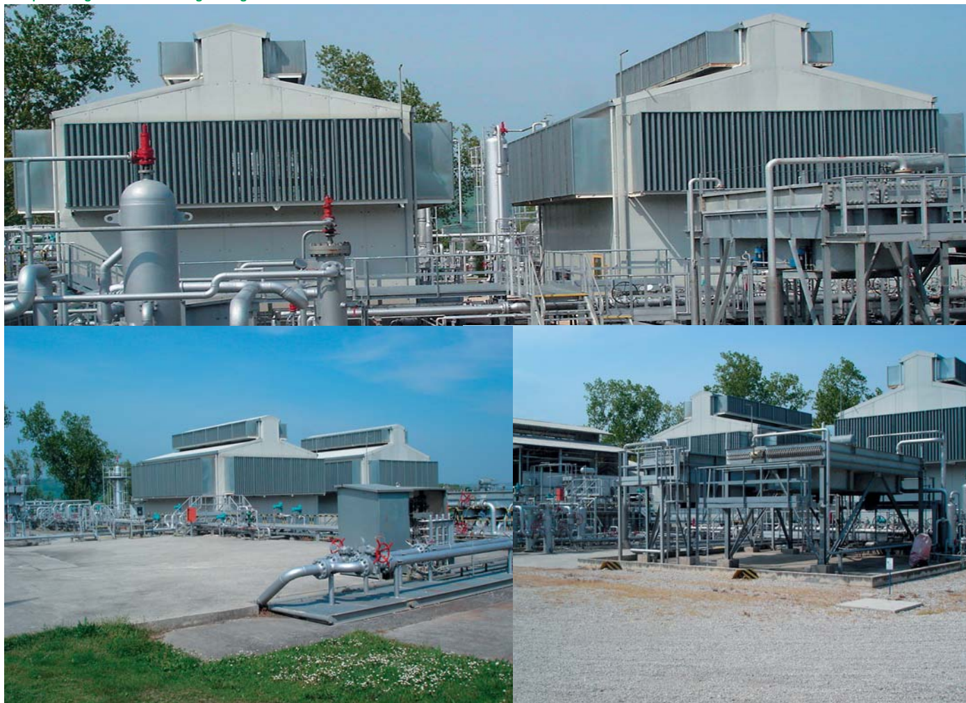
Compressori gas naturale e refrigeranti gas naturale
