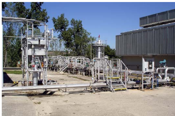
Parte d'impianto "skid di rigenerazione glicole trietilenico" e "colonna di disidratazione"
