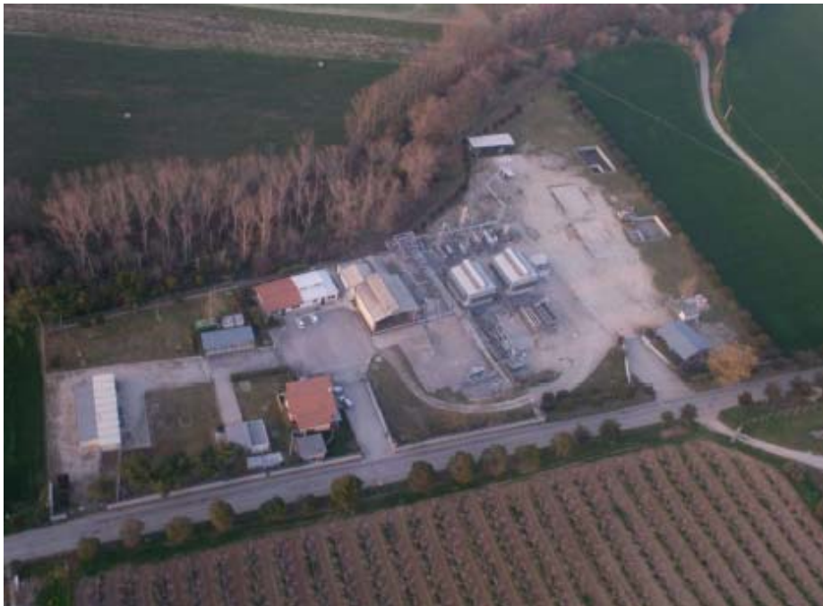
Vista della centrale di Cellino Attanasio Stoccaggio
