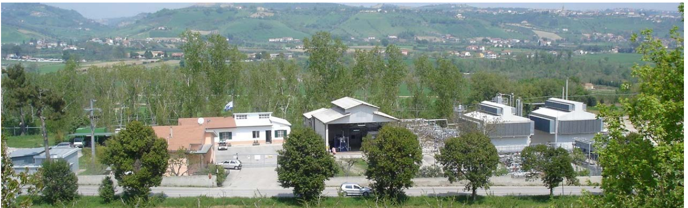
Vista della centrale di Cellino Attanasio Stoccaggio
